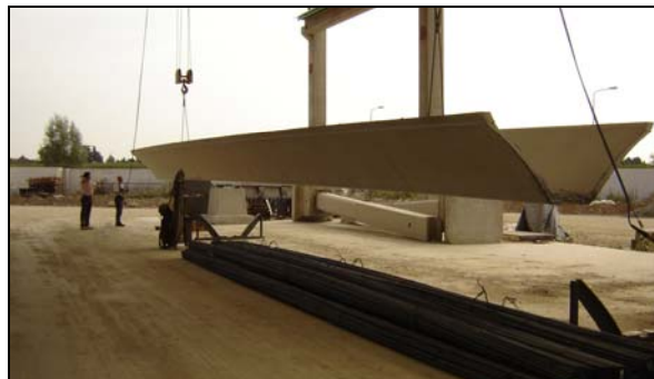
Figura 9: Posizionamento degli elementi
