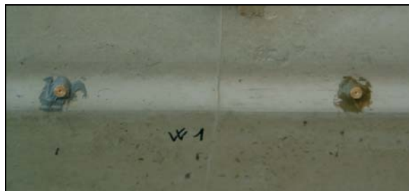
Figura 6: Particolare delle basette di riferimento per deformometro Whittemore
