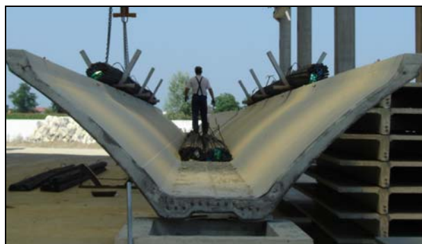
Figura 15: Vista del carico tegolo B
